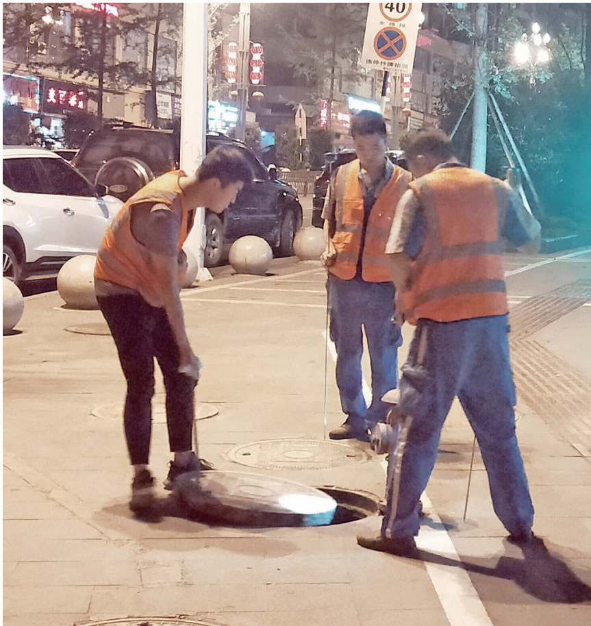
测漏人员在夜深人静时对管网进行测漏工作
