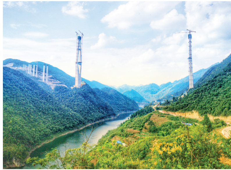
遵余高速湘江大桥施工时场景
