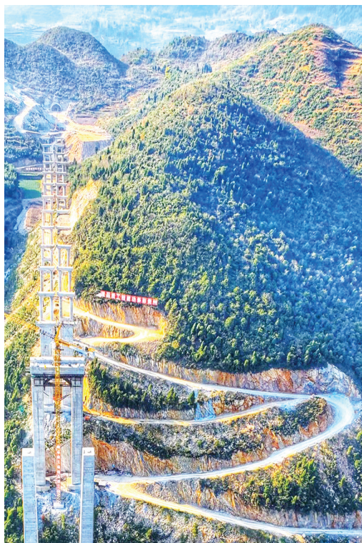
遵余高速公路湘江大桥引桥便道
