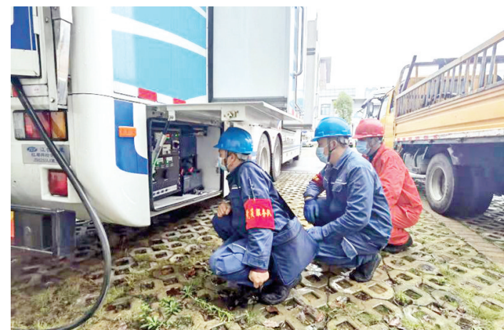
10月20日20时许,贵州省疾控中心承担支援任务的8辆移动微生物检测车抵达我市。根据新冠肺炎疫情防控保电方案,南方电网贵州遵义市郊供电局党员突击队经过通宵奋战,于21日6时完成8台检测车的电源安装任务,有力保障了核酸检测工作的顺利开展。(记者 杨露 摄)
