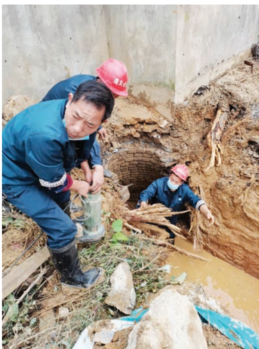
遵义市供水有限责任公司工作人员抢修漏水水管。
