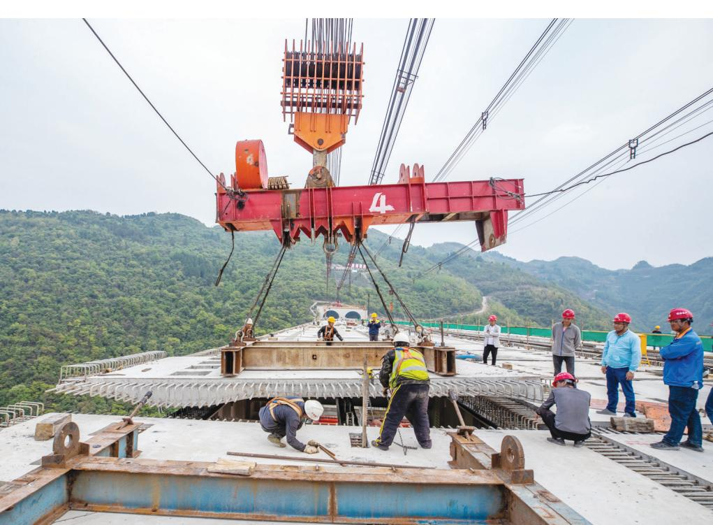
3月21日,仁遵高速大发渠特大桥桥面合龙。大发渠特大桥是仁遵高速的控制性工程,全长1427米,桥宽33米,双向6车道,是上承式钢管混凝土拱桥。
