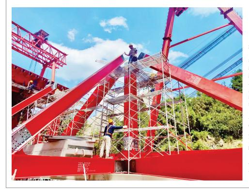
连日来,我市出现持 续高温。7月14日,在中 国中铁投资、中铁广州工 程局承建的金(沙)仁(怀) 桐(梓)高速桐梓河特大桥 建设工地上,建设工人们 正顶着炎炎烈日拼装钢桁 梁。桐梓河特大桥是金仁 桐高速公路的控制性工 程,也是目前贵州省在建 的第二大跨度山区峡谷区 悬索桥,主桥为双塔单跨 钢桁梁悬索桥,主跨965 米, 塔高208米, 桥梁全长 1422米。为了加快施工 进度,项目部制定了详细 的节点目标,采取优化施 工方案等措施,确保钢桁 梁顺利吊装。
