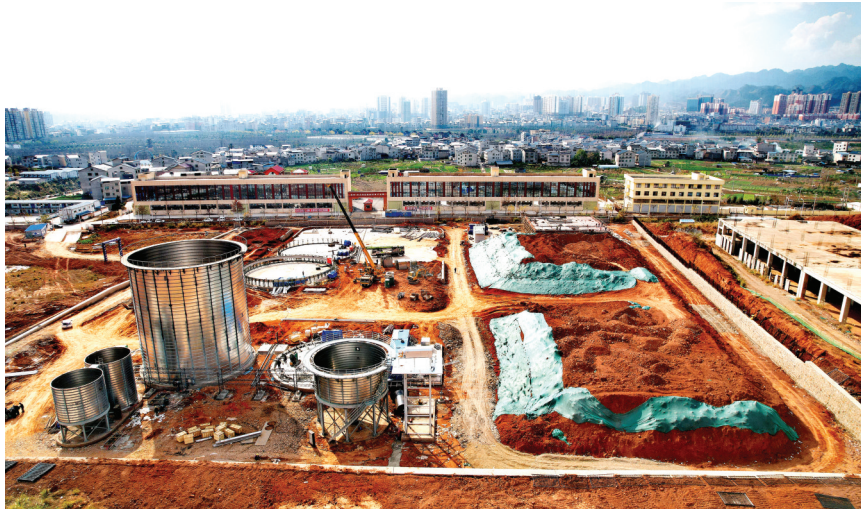
余庆县河东综合片区污水处理厂服务项目占地20亩，总投资超1.5亿元。项目主要建设包括日处理能力为3000吨的污水处理厂、4公里的污水管网及配套基础设施等。图为项目建设现场。
