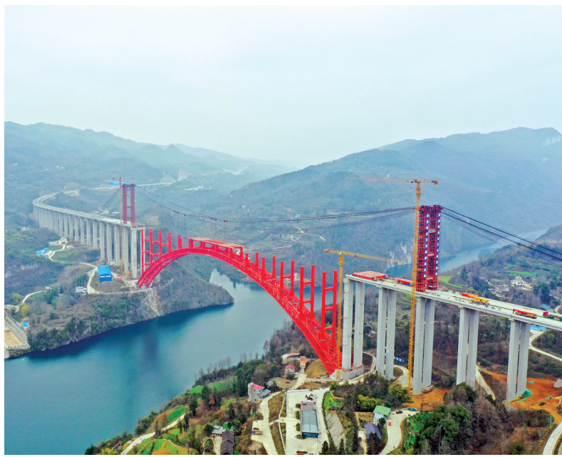
施工中的乌江特大桥。
