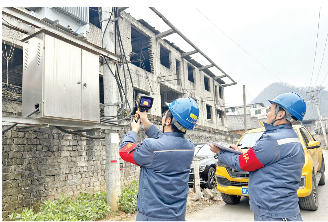
连日来，南方电网贵州遵义市郊供电局结合电网迎峰度冬和近期气候变化情况，组织各供电所工作人员通过在线监测、线路测温、“人+机”巡视等方式，对辖区内各输电线路、供电设备等进行全面的巡视检查和红外测温，确保辖区内群众冬季安全可靠用电。 (记者 吴凡 摄)
